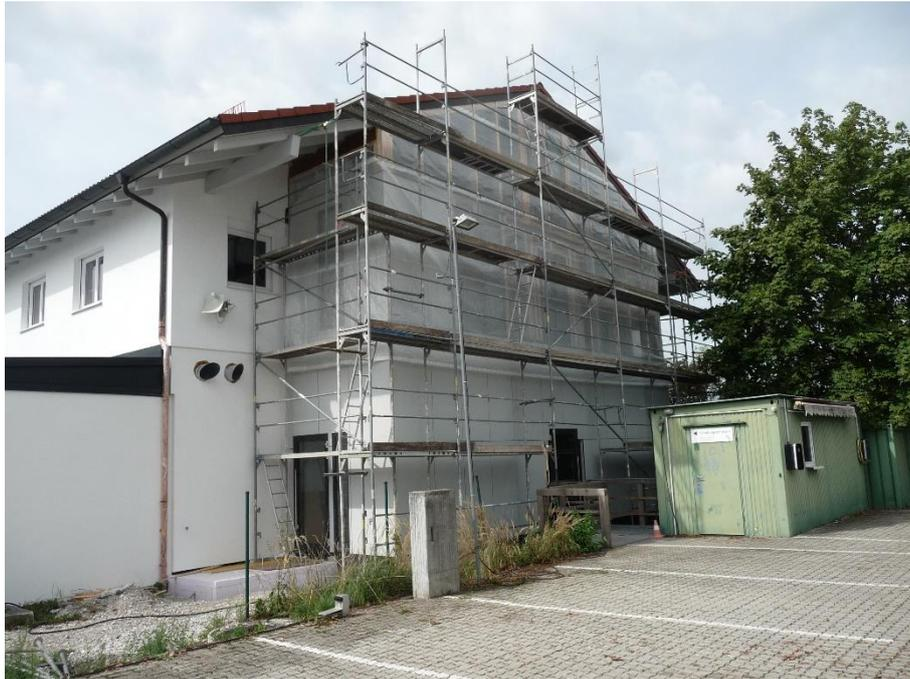
Abbildung 27: südliches Bestandsgebäude ESZ AG (Gebäudenordseite) in Sanierung und Umbau mit dicht verhängter Fassade ohne Schlupflöcher (Stand September 2023), (Renner, 2023)
