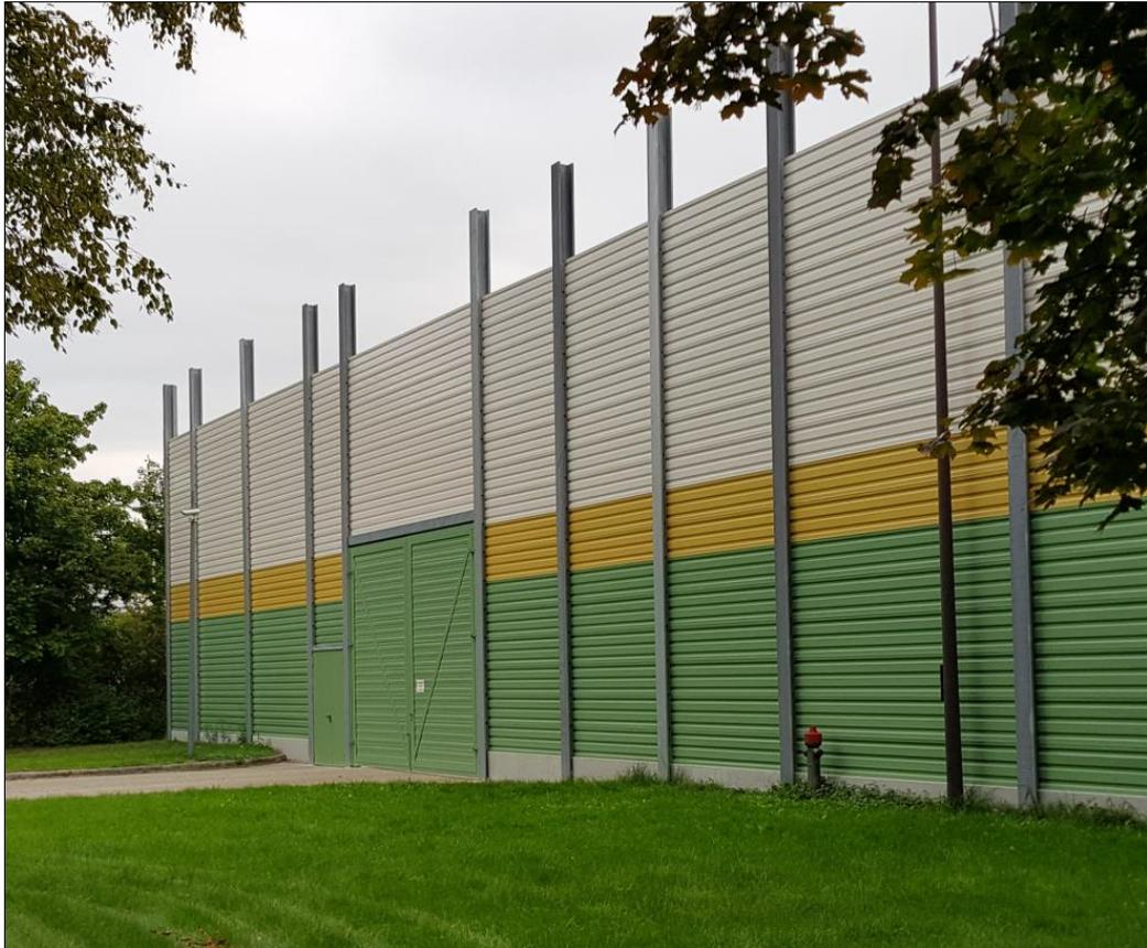
Foto 1. Sicht von Südwest auf den gegenständliche Bauantrag mit den von 8,4 m auf 10,0 m auszufachenden IPB-Trägern/-Stützen.
